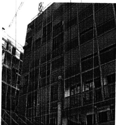
Figure 34 : Stores enroulables (logements à Barcelone Arch. Pich y Aguilera Source: Google images
