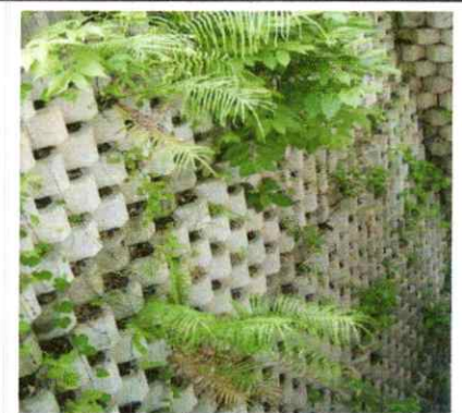
Fig29 Mur vertical végétalisé
