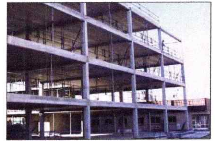
Figure 41 Ossature en béton armé
