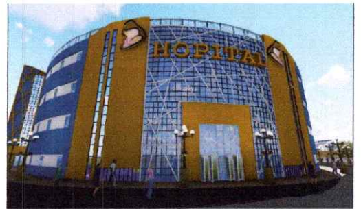
Fig 53 du projet : Façade mur rideau
