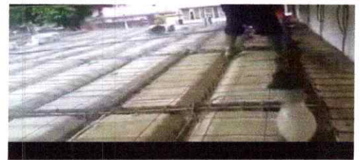
Figure 52 dalle en Corps creux polystyrène
