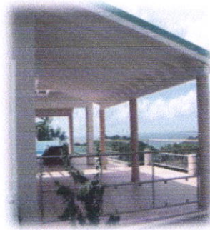
Figure 19 : Terrasse couverte pour se protéger de l'ensoleillement.
