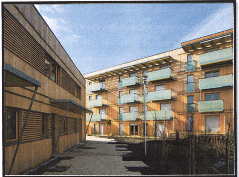
Figure 31 : façade intérieure de 77 logements sociaux
