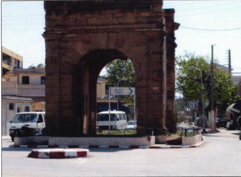
Fig.2.32. Image qui montre le nœud de Bab el Gharb.
