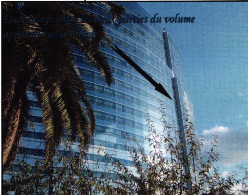
Fig.3.51.détail de joint de rupture dans la façade principale de l'hôtel Sheraton Oran.
