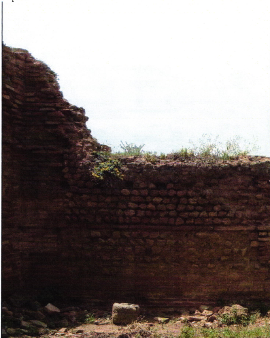
Fig.2.61. Image d'un appareillage Mixtum à bandes.
