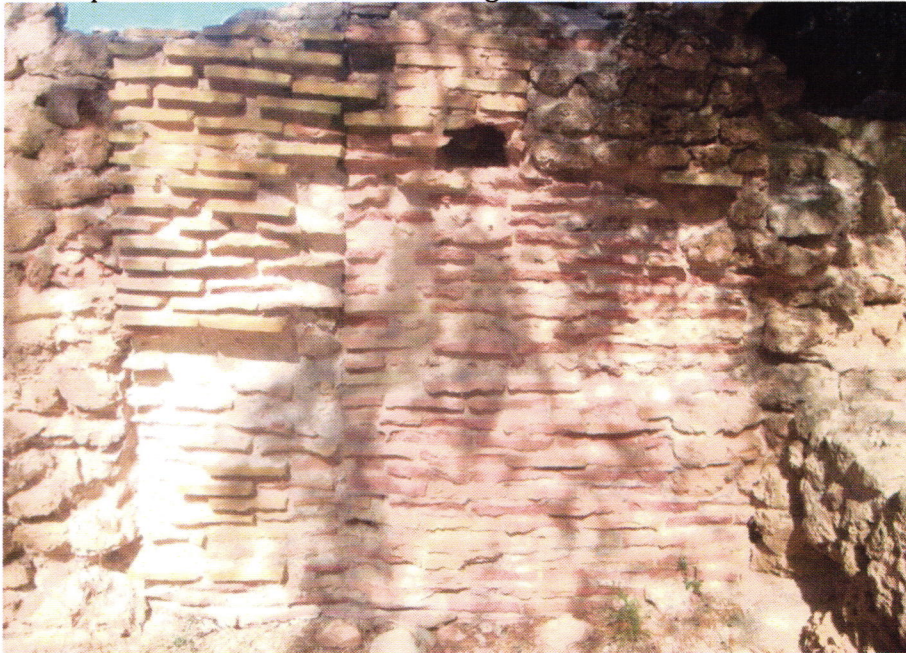
Fig.2.59. Image d'un appareillage Opus Latericium.
