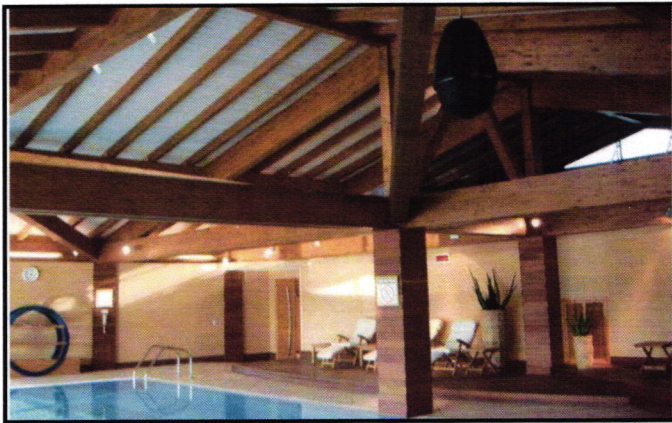
Fig.3.51.détail de la toiture en bois de la piscine.
