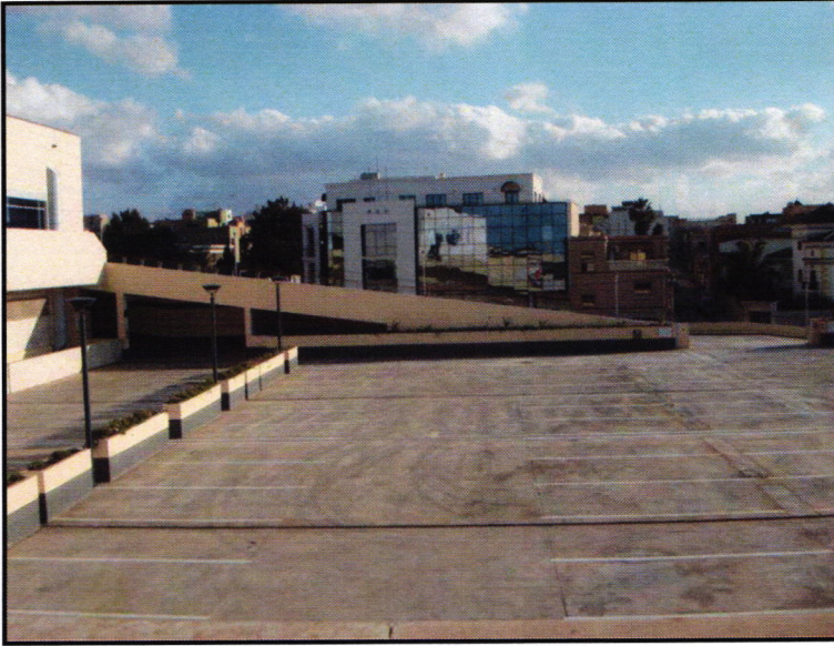
Fig.3.24.vue du parking extérieur de l'Hôtel Sheraton Oran.
