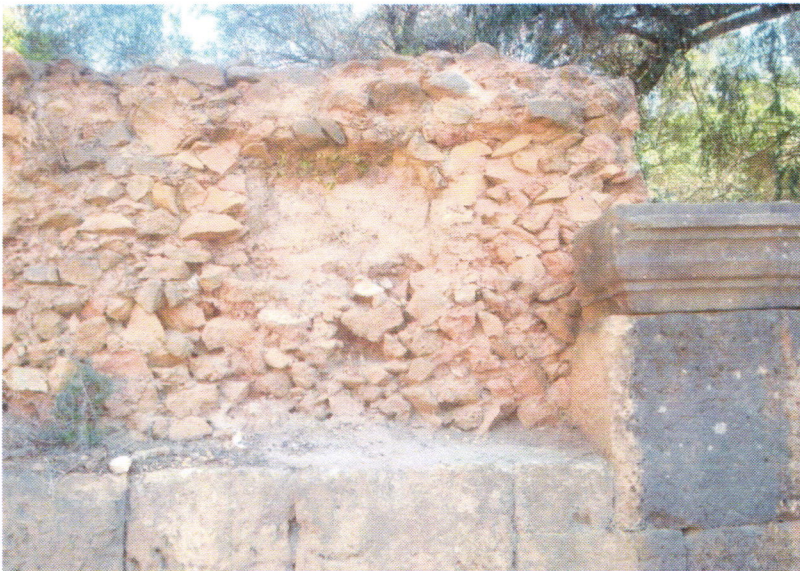
Fig.2.58. Image d'un appareillage Opus caementicium.
