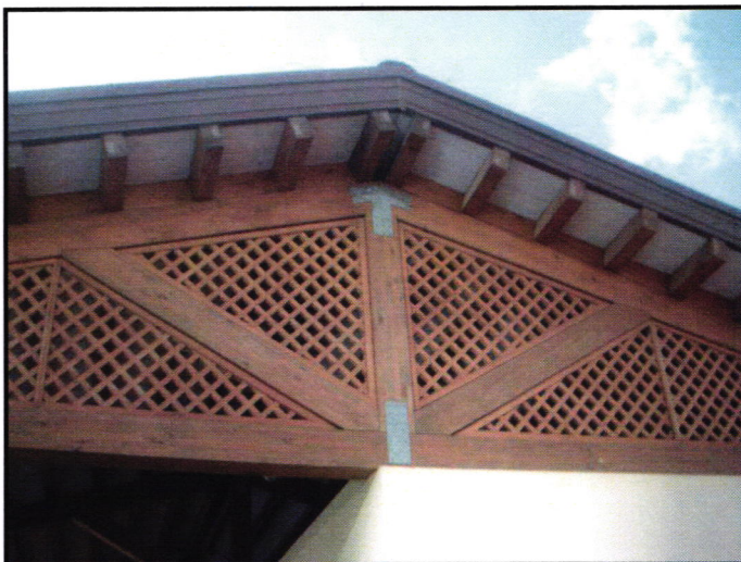
Fig.3.52.détail de la toiture en bois de la piscine.
