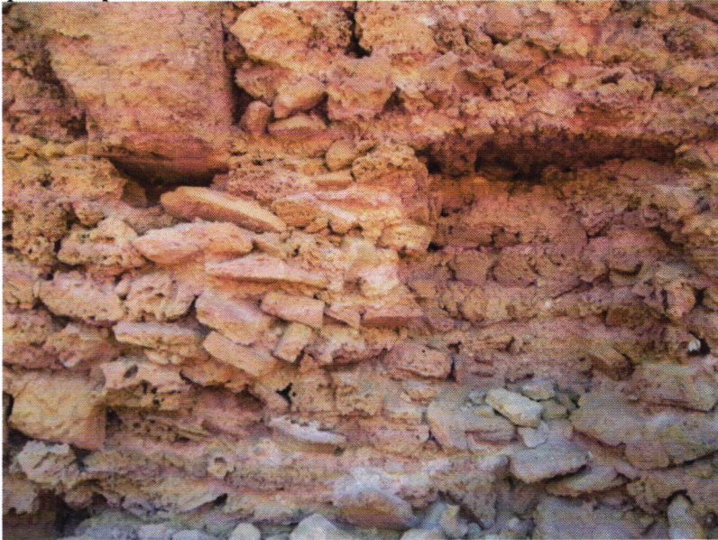
Fig.2.57. Image d'un appareillage Opus caementicium.
