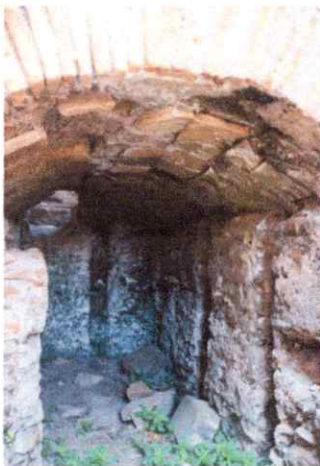
Figure34 : Fondations coffrées, source : archéologie construction romain
