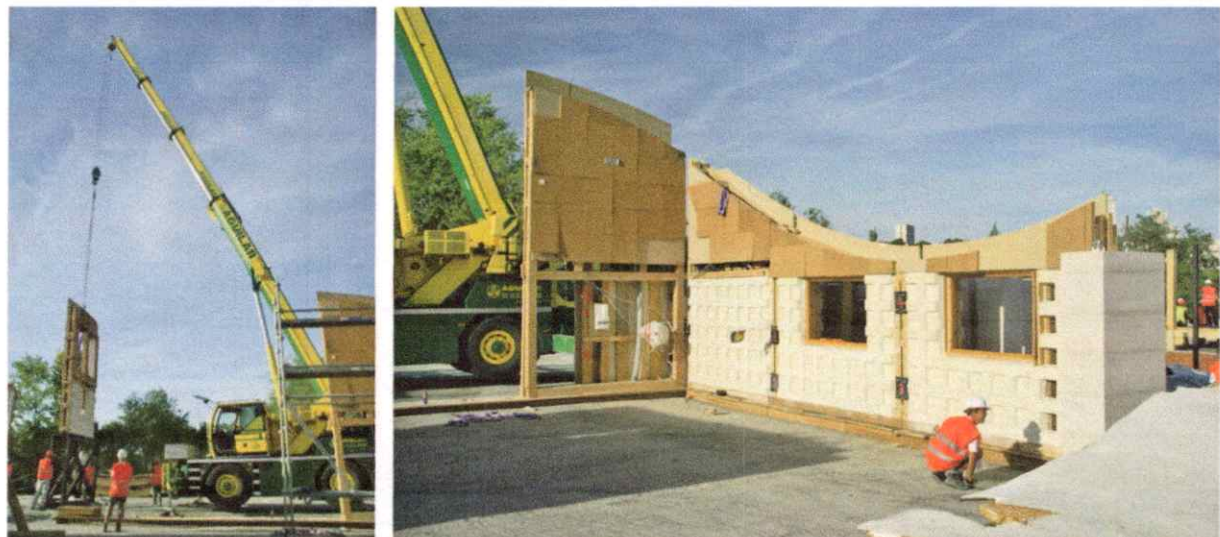
Figure 64. Levée finale de la structure sandwich vertical et le montage du mur est. source : Journal of Space Structures
