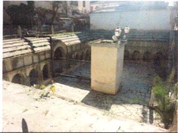
Figure 17 : château d'eau romain, source : l'auteur
