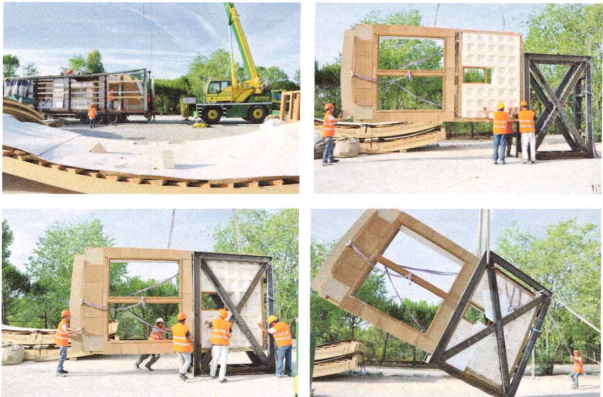
Figure 63. Étapes préliminaires d'une installation murale: le déchargement et la rotation de la structure en sandwich en utilisant un châssis en acier pour le protéger et une grue. source : Journal of Space Structures
