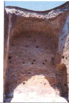
Figure 41 : Voûte d'arête, source : IDEM
