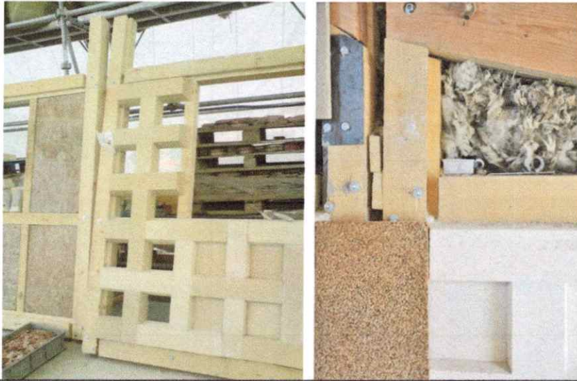
Figure 60 :Image de gauche montre les panneaux qui constituent la structure sandwich. Le panneau de gauche, partiellement visible, n'est pas fini (seule la charpente en bois est assemblée) tandis que l'autre a les pierres déjà placées. Photo à droite montre un détail de l'assemblage de deux structures sandwich à travers les cadres en bois. Il est également possible de voir les quatre matériaux naturels utilisés: bois, liège, pierre et laine de mouton, source : Journal of Space Structures
