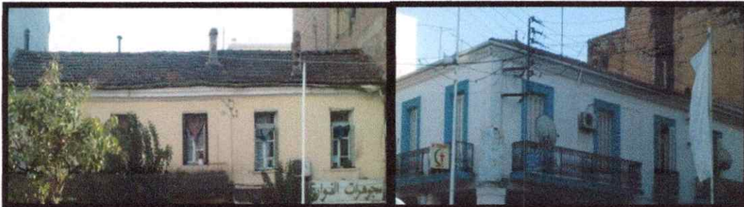
Figure 33 : fenêtres et les portes balcons, source : l'auteur
