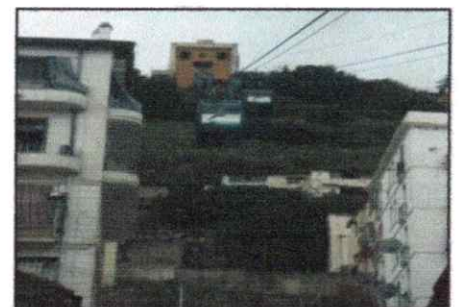
La ligne du téléphérique
