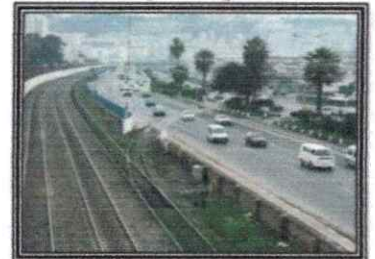
La voie ferrée
