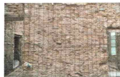
Mur porteur en maçonnerie mixte (pierre et brique) avec grande proportion de pierres moellons
