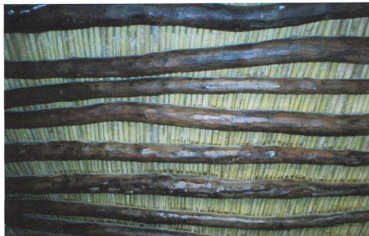
fig29 : Plancher sur rondins de thuya et branchages
