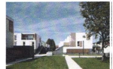
Fig. 47 : Logements sociaux PLA à Brive (2002), Françoise Risterucci
