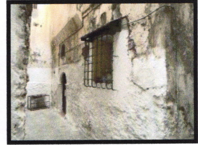
Figure 1.29 : Mur en pierre
