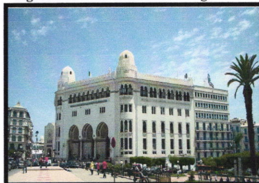
Figure 1.49 : La grande poste à Alger
