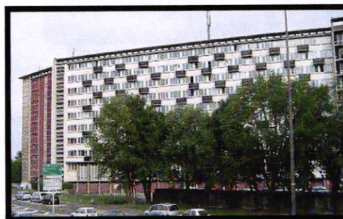
Figure 1.58 Résidence Jen Zay en France
