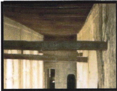
Figure 1.27 : Les rondins en bois (Poutrelles)
