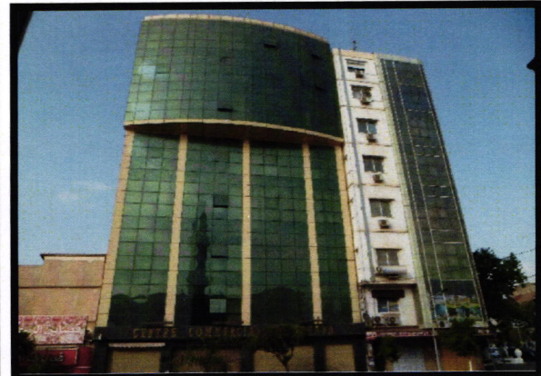
Figure 3.21 Le mur rideau sur le centre commercial el Manara a Blida
