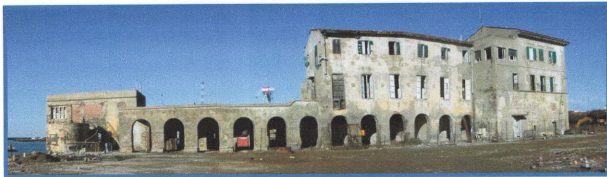
Fig.14 : image de l'équipement entrain les travaux
