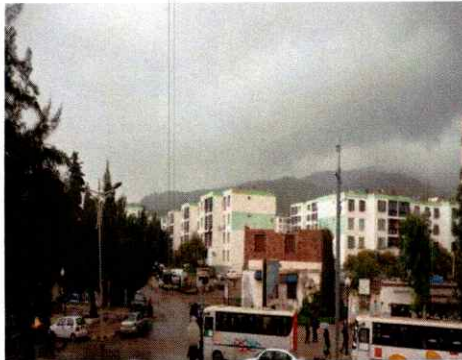
Figure 20 : Cité des 402 Logements
