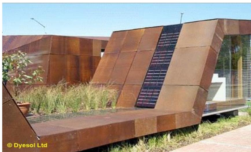
**Figure 2.6:** vitre semi réfléchissante en DSSC [37]
