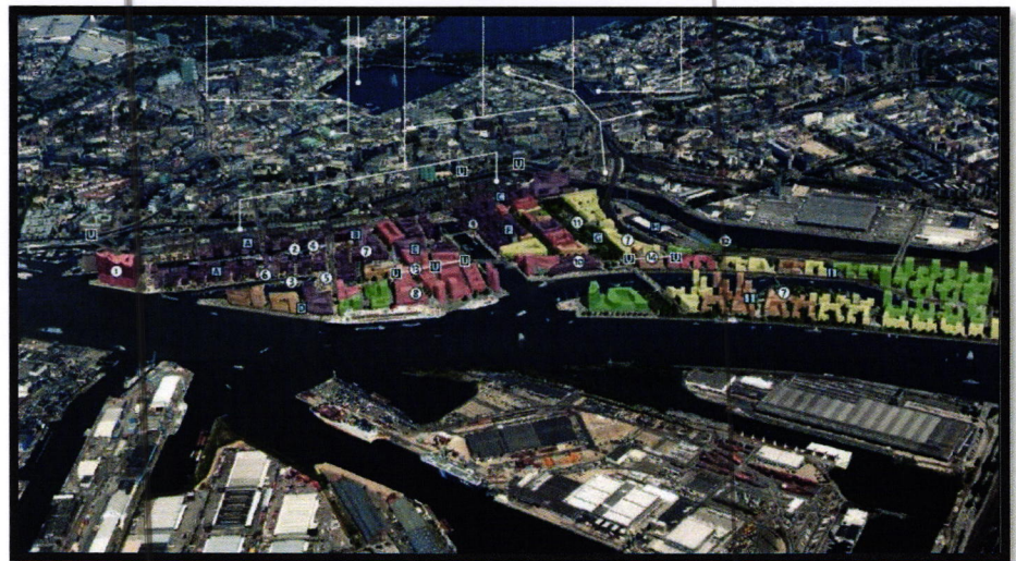
Figure 3.15 : Vue aérienne avant et après l'opération www.hafencity.com
