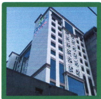
Figure 3.65: Bâti en bonne état (l'hôtel OASIS)
