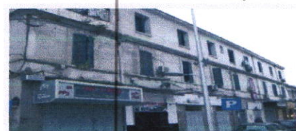
Figure 3.49: Vue de l'extérieur de la maison Source : Archive d'Hussein dey
