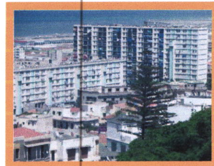
Figure 3.67 : Bâti en moyen état (cité mer et soleil)
