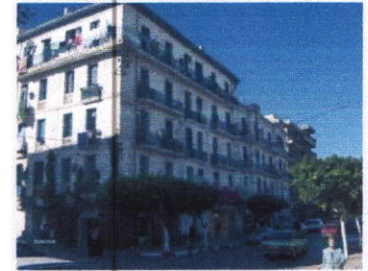
Figure3.53 : Vue de l'extérieur de la maison Source : Archive d'Hussein dey
