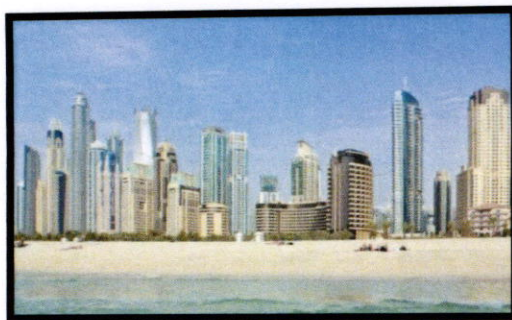
Figure 13 : 7 Façade urbaine de Dubaï.
