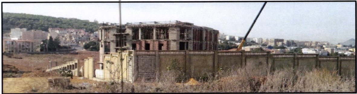
Figure 31 : Photo d'une construction en cours de réalisation
