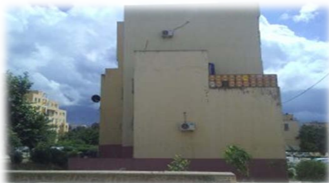
Photo12: le bloc qui était l'objet d'un relevé architectural (vue prise par l'étudiant)
