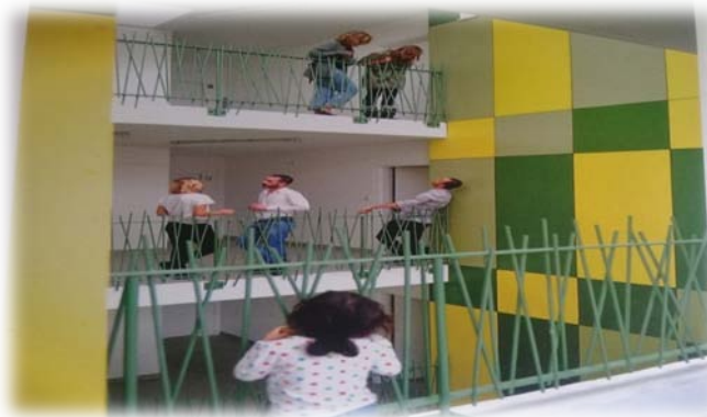
Image27: escalier Assurant davantage l'urbanité
