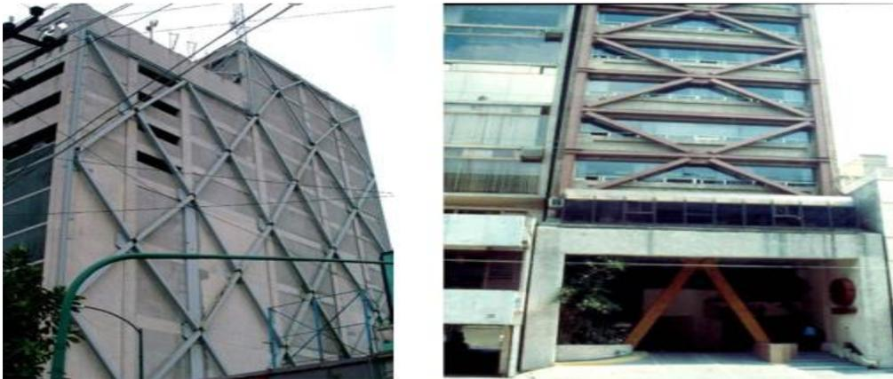
**Figure 1.18** Renforcement métallique
