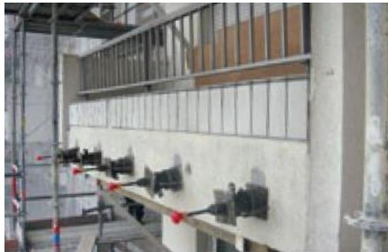
**Figure 1.16** Renforcement par précontrainte additionnelle
