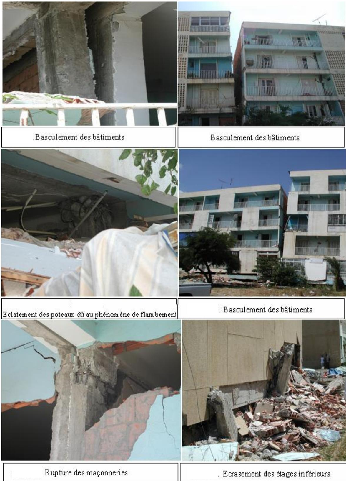
**Figures 3.3.** Dommages réels aux bâtiments de la Cite 1200 logements suite au séisme de Boumerdès
