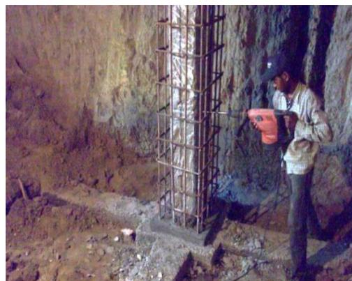
**Figures 1.11 a-b.** Mise en place des armatures
