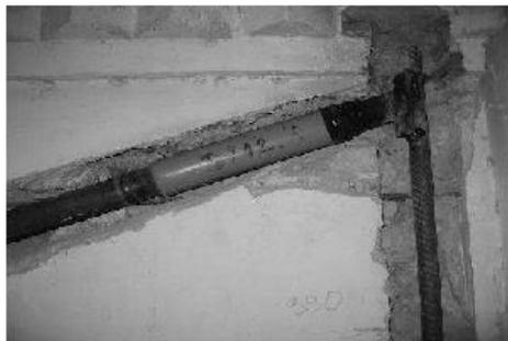
**Figure 1.23.** Détail du renforcement par le système d'amortisseur DC-90
