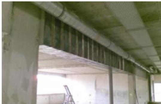
**Figure 1.17.** Renforcement par TFC
