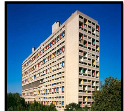
Fig. 3 cité radieuse à Marseille
