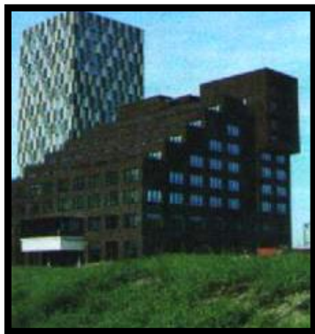
Figure 14 : Photo de l'immeuble
