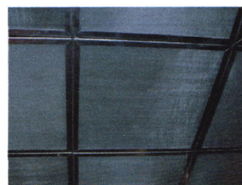
Fig 47 : vue sur le faux plafond .
