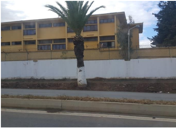
Photo2.2: Vue n° 01 l'aérodrome (architecture coloniale)
