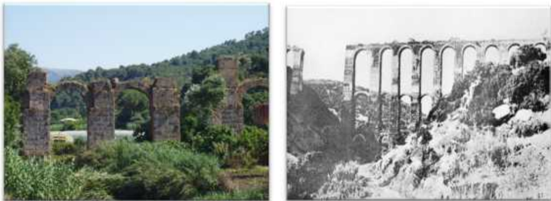
Fig 51: L'aqueduc (Pont) de l'Oued el Ballah
