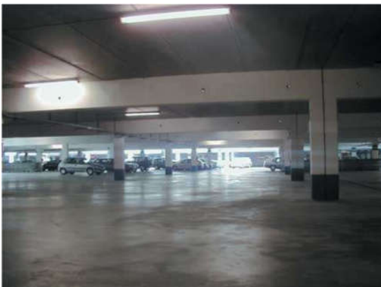
Figure 42: d'un parking avec un système constructif portique
