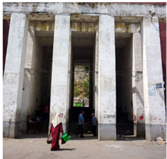
Figure 54: photo des piliers
