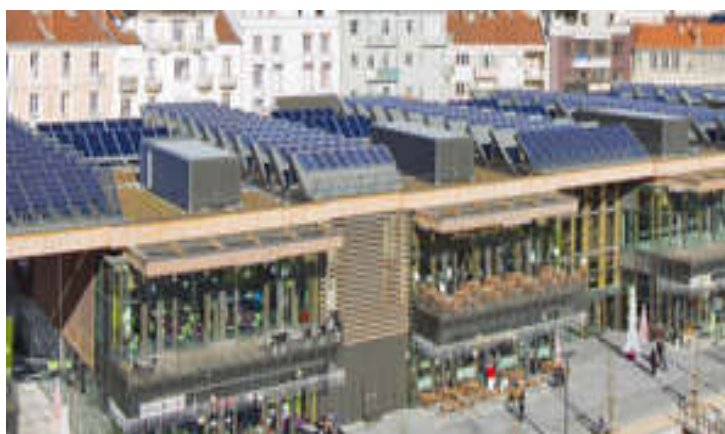
Figure 25: panneaux photovoltaïques en toiture de l'espace commerciale source : Google image
