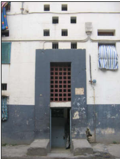
Figure 61: les ouvertures de la cage d'escalier source : fernandpouillon.com
