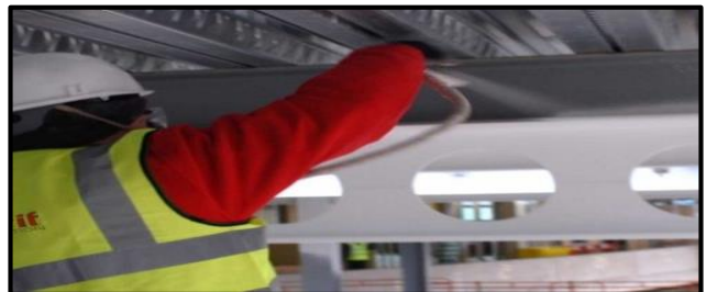
Figure 121 : protection par flocage Source : site web : //www.google.dz/
