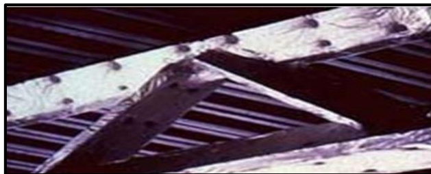
Figure 125 Charpente protégée par laine minérale Source : site web : //www.google.dz/
