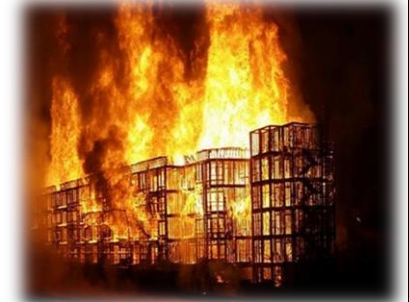
Figure 108 Effet de l'incendie Source : site web : //www.google.dz/
