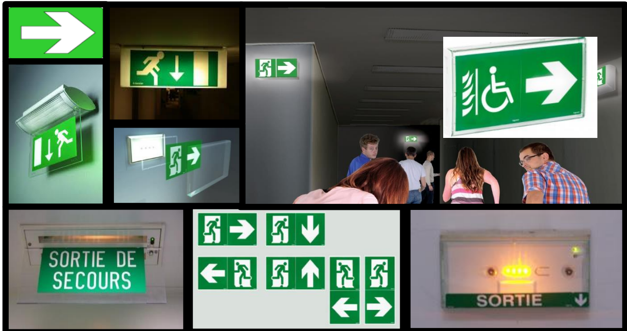
Figure 98 Eclairage de sécurité Source site web : //www.google.dz
