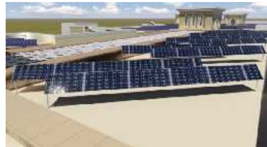
Figure 93: Les capteurs solaires thermiques sur le projet Source: auteurs, 2017
