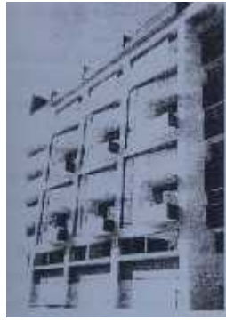
Figure15: Réponse architecturale a la protection solaire : loggias et l'effets de flanc sur l'immeuble Source : Izard, 1993, cité par Magri Elouadjeri, 2009
