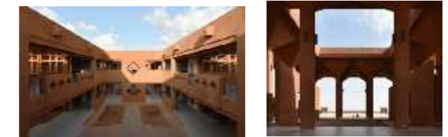
Figure 35: patio de l'hôpital source : www.archdaily.com
