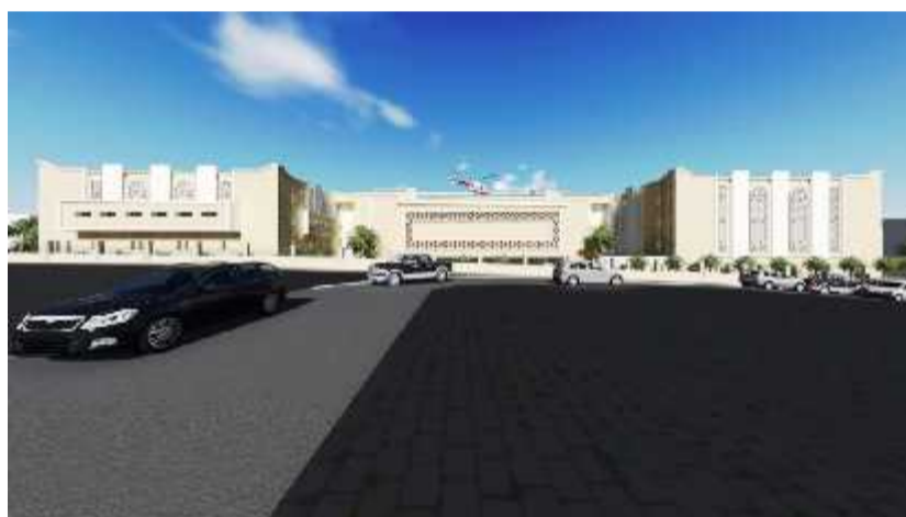
Figure 67 : Façade Sud- Est Source : Auteurs ,2017.
