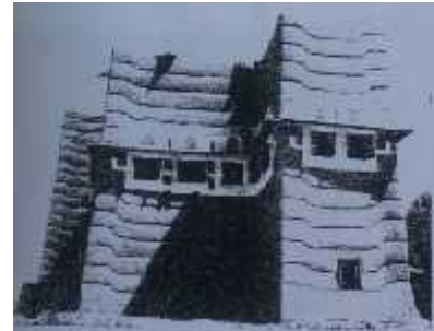
Figure18: Une construction en terre crue, un moyen de bénéficier d'une inertie thermique Source: : Magri Elouadjeri, 2009
