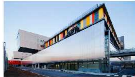
Figure27: Vue générale façade Nord du nouveau centre hospitalier sud Francilien source : www.groupe-6.com
