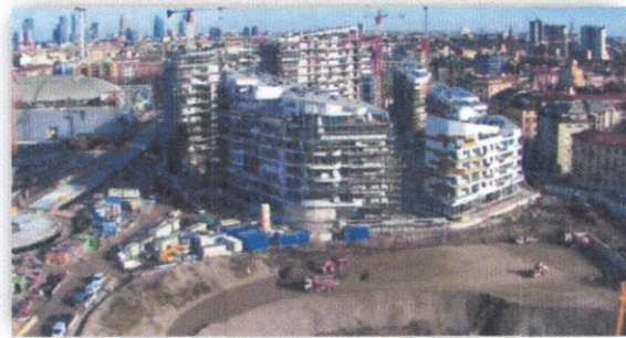
Fig 77-: Le chantier du projet
