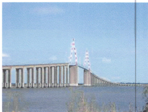
Figure 7: vue sur la passerelle Source : http://insitu.revues.org/
