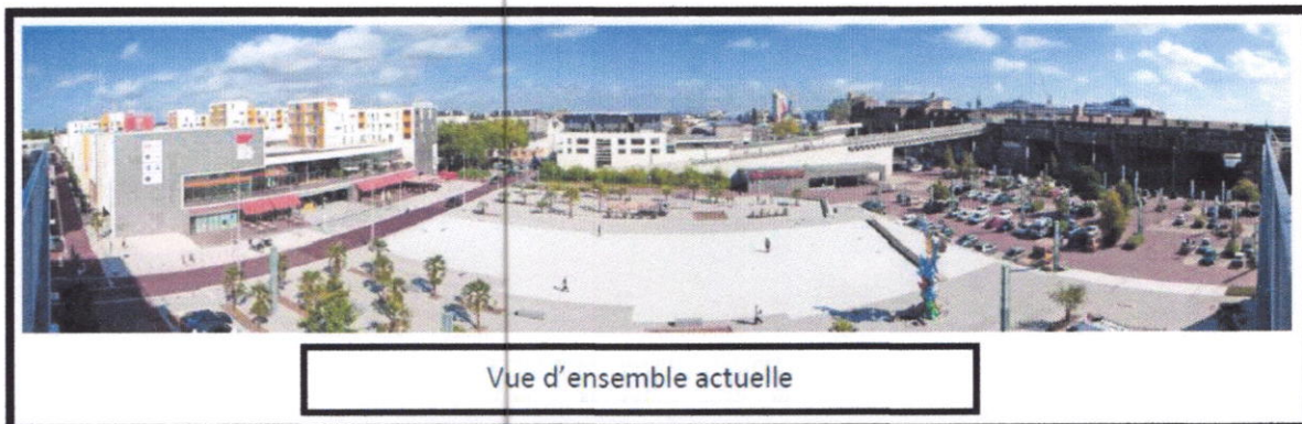
Figure 11 : vue d'ensemble actuelle
