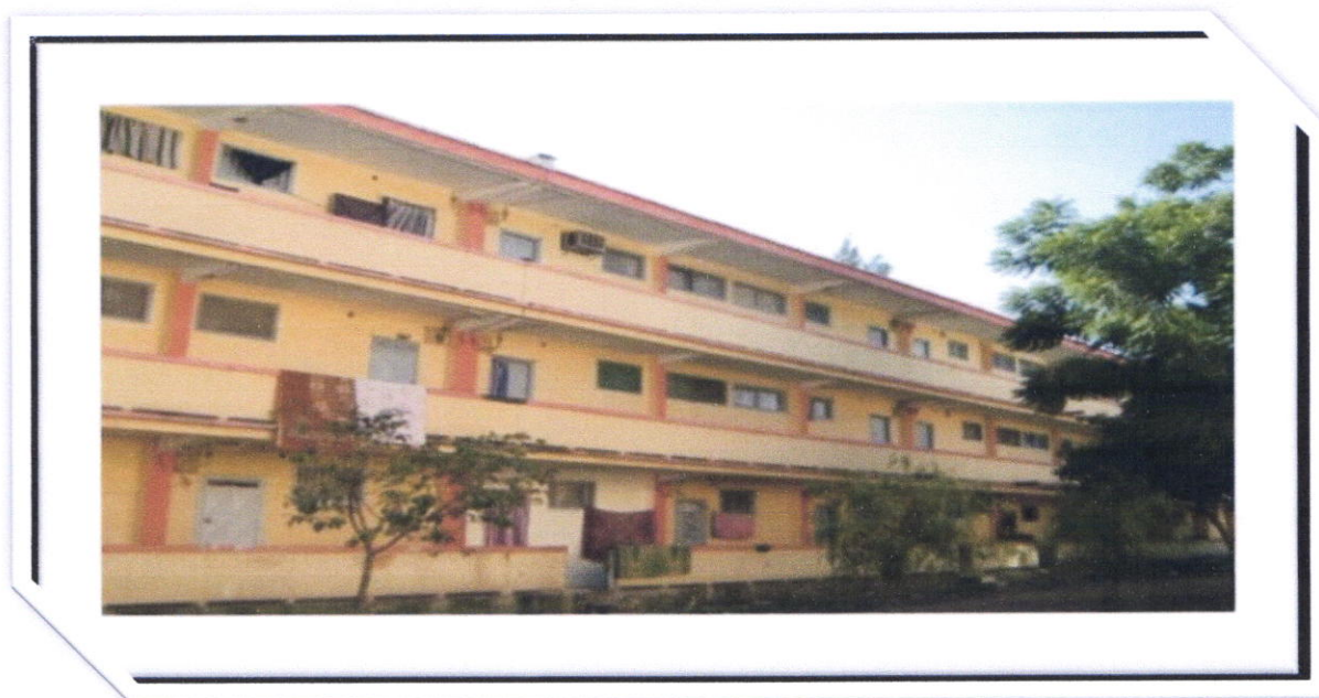
Fig. III-1: Une bâtisse d'une cité a Bejaia qui est une ville littorale
