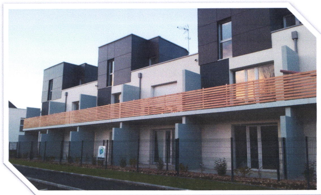
Fig. II- 3 : exemple d'habitat semi collectif.
