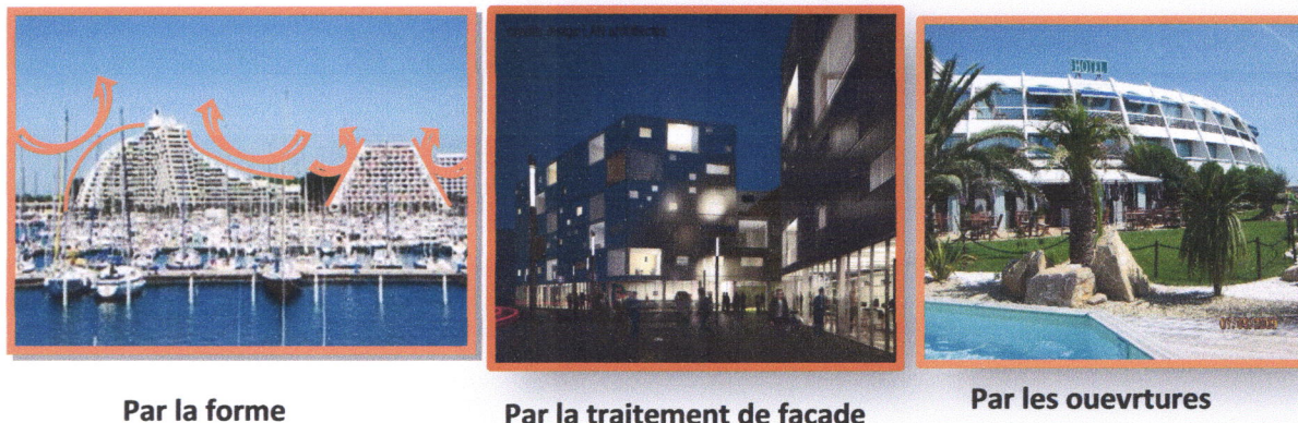
Fig. I- 2 : photos des bâtiments montre la spécificité de littorale.
