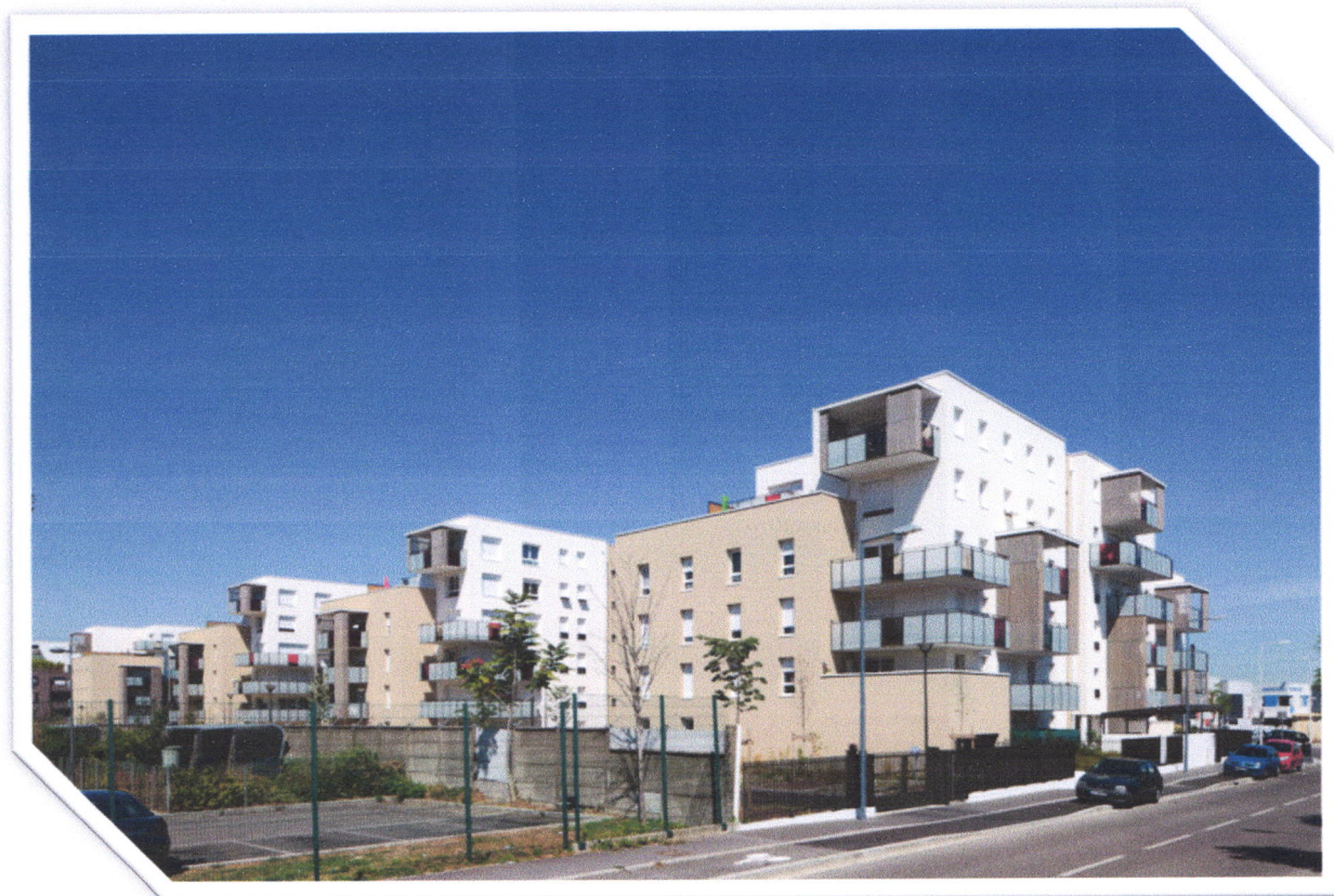
Fig. II- 2 : exemple d'habitat collectif.
