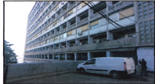
Figurell-16 : l'immeuble 2 Source : Auteurs 2017
