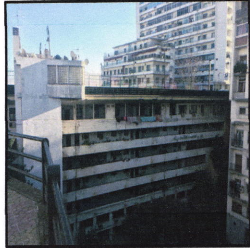
Figure II-37 : Façade sud Source : Auteur 2017
