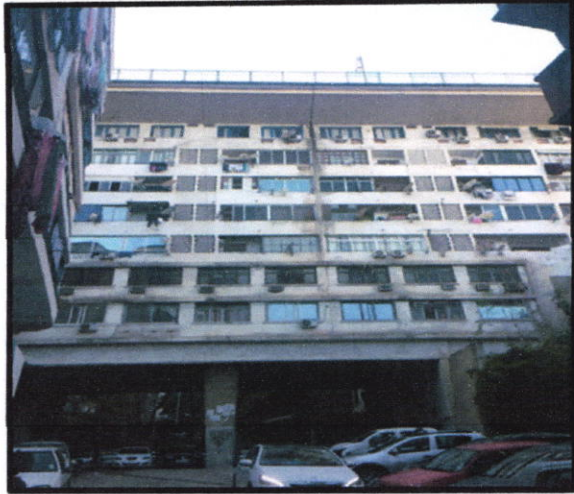
Figure II- 36 : Façade nord Source : Auteur 2017
