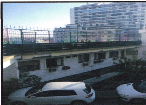
FigureII-34: Le pont. Source : Auteur 2017.
