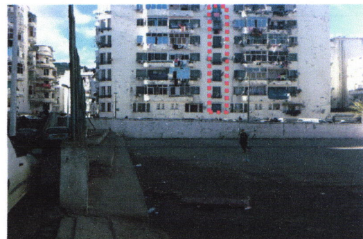
Figurel-65 :Façade des HBM à Bab-El-Oued Source : photo prise par auteur 2017
