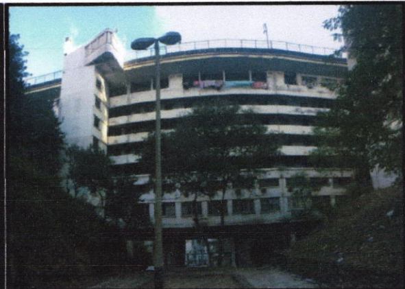
FigureII-35 : Image qui montre l'intégration du bâtiment. Source : Auteurs 2017.
