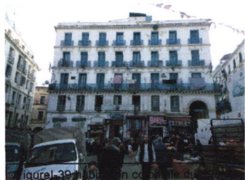
Figurel-39:habitation coloniale du 19eme siècle à Bab-El-Oued Source : auteurs 2017
