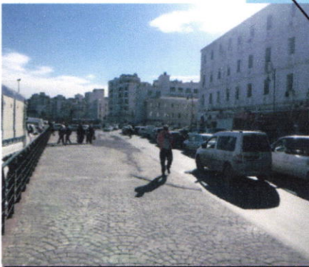
Figurel-79 L'avenue Commandant Mira Source : auteurs 2017
