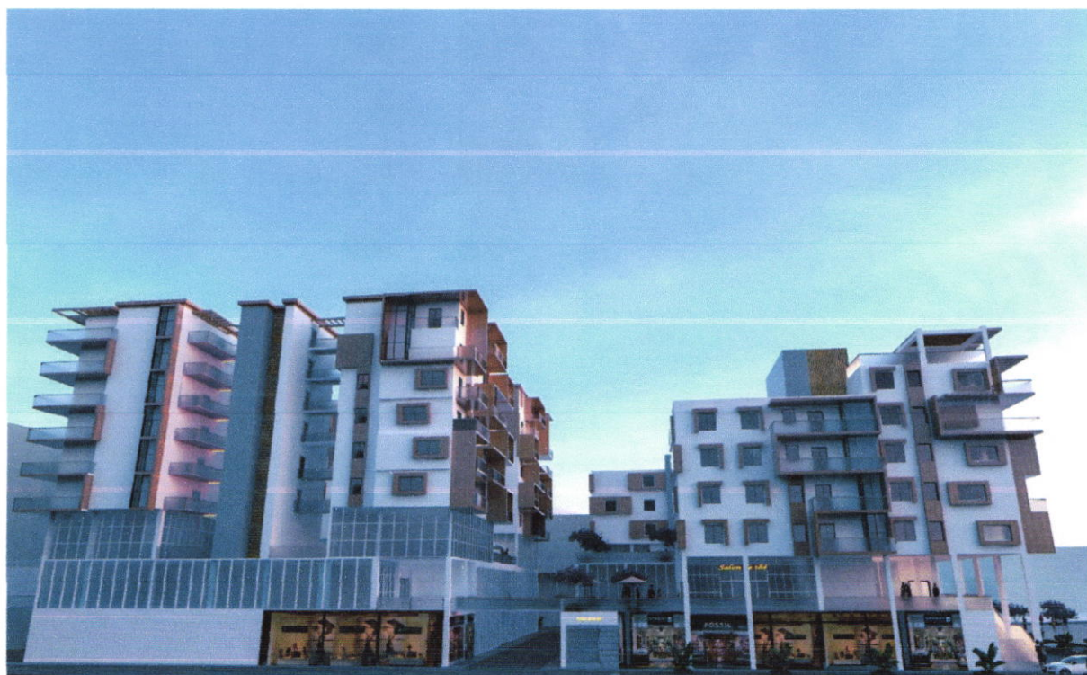
FigureIII-43 : Vue sur la façade postérieure du bâtiment02 ou nous voyons la passerelle qui relie les deux terrasses publiques du bâtiment 01 et le bâtiment de derrière, nous voyons aussi la terrasse des habitants et la place publique de notre projet de loin Source : Auteurs 2017
