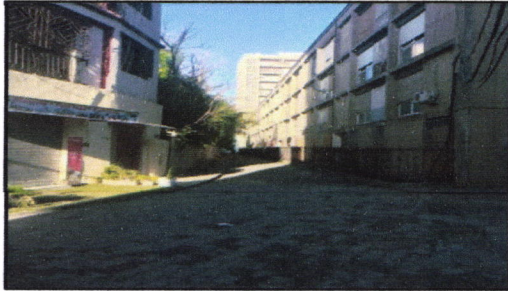
Figurell-15: l'immeuble 3 Source : Auteurs 2017
