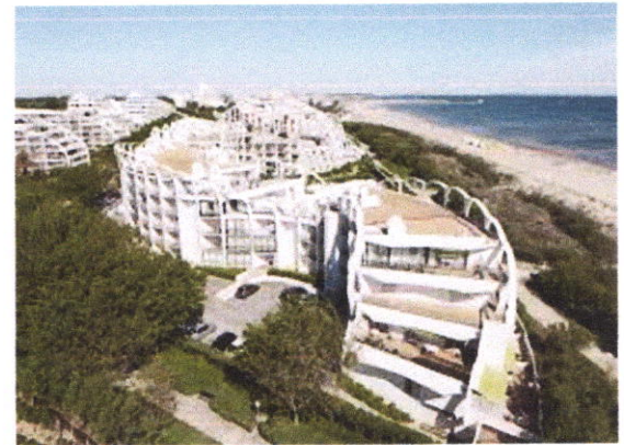
Image03 : la grande motte France, la forme convexe pour se protéger des vents et profiter de la vue panoramique par les terrasses et balcons. Source : https://encrypted-tbn0.gstatic.com
