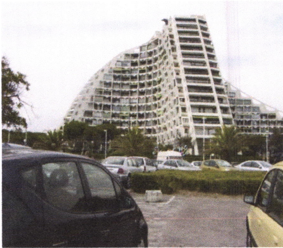
Image01 : La grande Motte-France- protection du rayonnement solaire par les Balcons et terrasses. Source: https://media-cdn.tripadvisor.com
