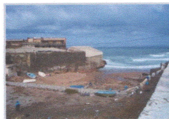
Figure47 : Etat des plages délaissées.
