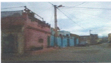
Figure52 : l'état de bâti en dégradation avancée.
