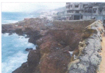
Figure46 : L'état des falaises en détérioration continue.
