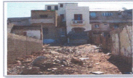
Figure51 : dégradation de l'environnement des constructions au bord de mer.
