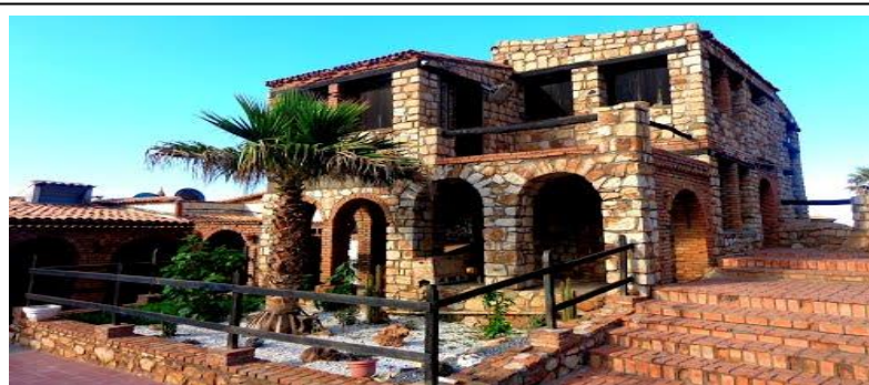
Figure50 : auberge du Thaïs, Bejaïa source : http://www.s2stravel-algerie.com
