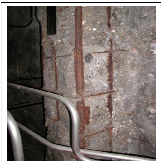
Figure29 : effet de corrosion. source : Google image
