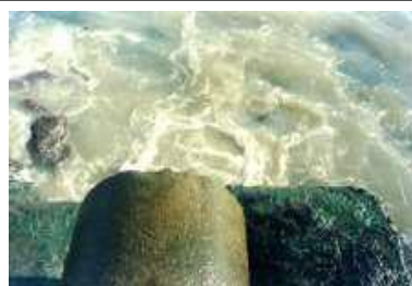
Figure40 : rejet des eaux usées, Ain Beniane , Algérie, source : Google image
