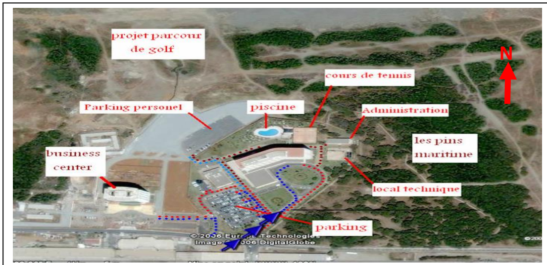
Figure61 : Photo aérienne de l'hôtel Hilton, Alger
