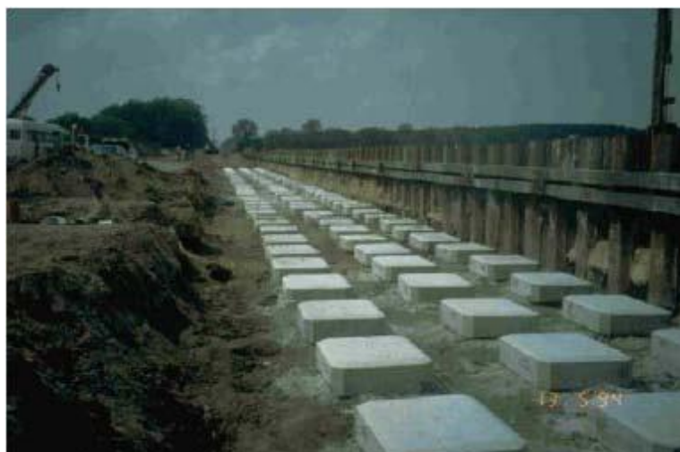
Figure I.19 : Chantier de remblai ferroviaire, visualisation des têtes d'inclusion avant l'édification du remblai. [3]
