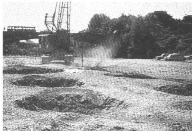
Figure I.9 : Chantier de pilonnage. [7]
