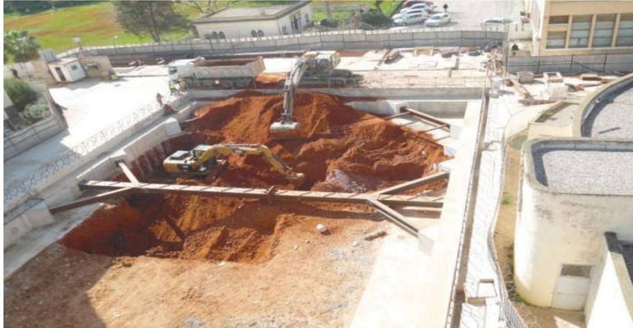
Figure III.29 : Excavation de la fouille.
