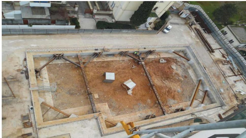
**Figure III.28 : Mise en place du premier niveau de butonnage.**
