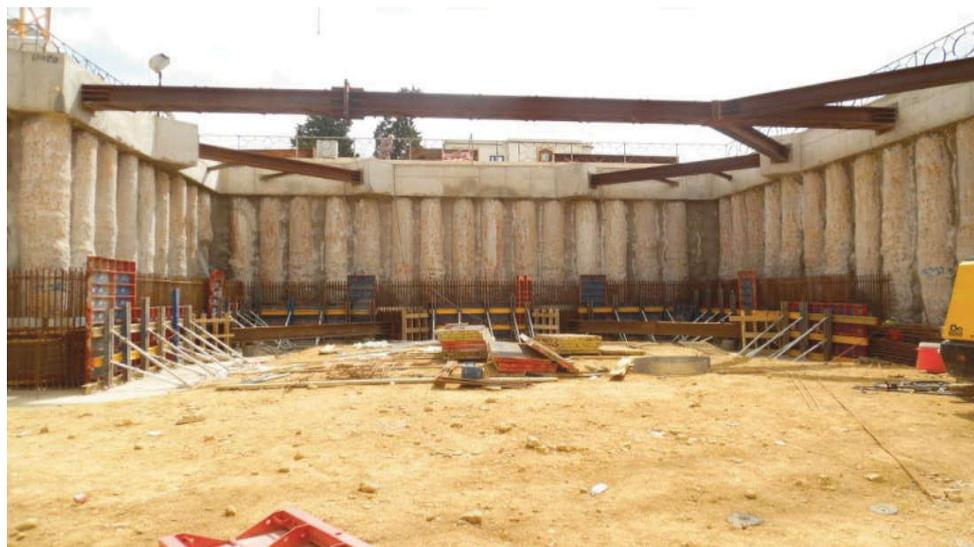
Figure III.30 : Mise en œuvre de la poutre intermédiaire.
