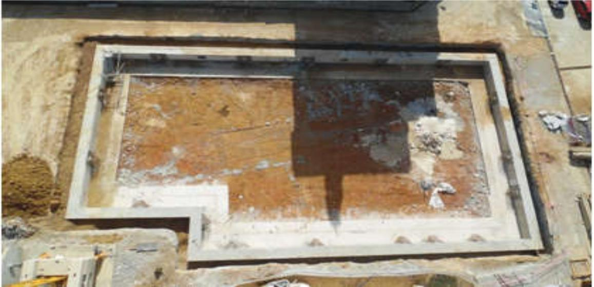
**Figure III.27 : Poutre de couronnement.**
