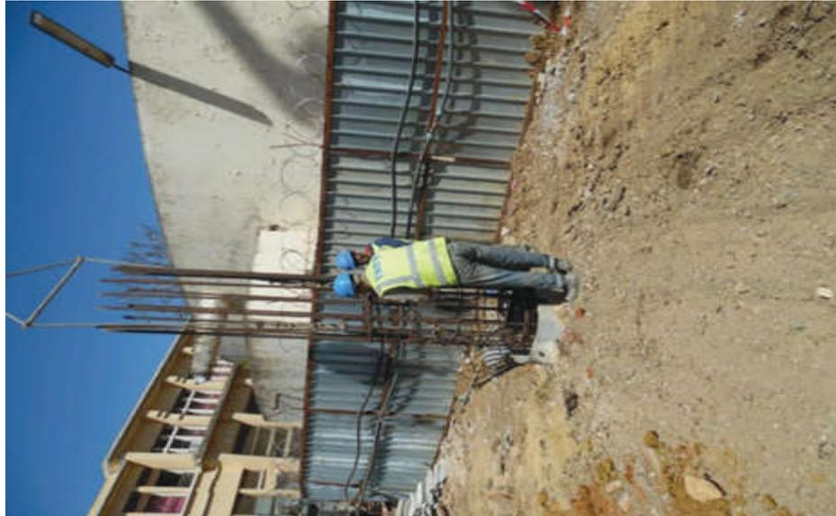
Figure III.19 : Mise en place des cages d'armature.
