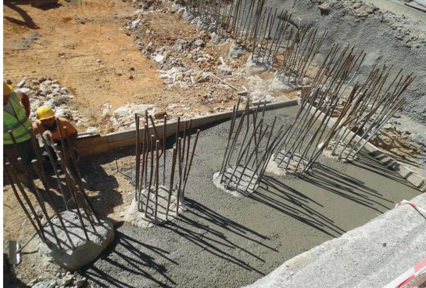
**Figure III.23 : Mise en place d'un béton de propreté.**
