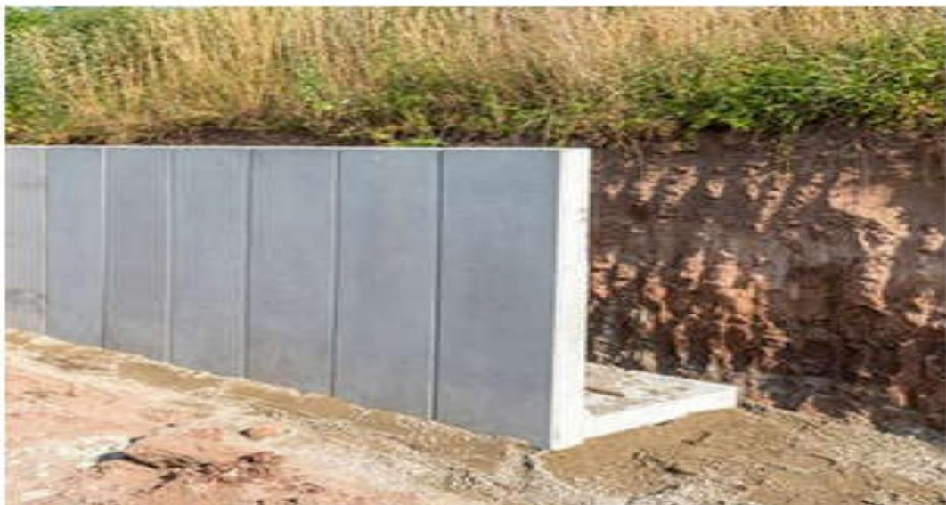
**Figure II.15 : Un mur cantilever. [10]**
