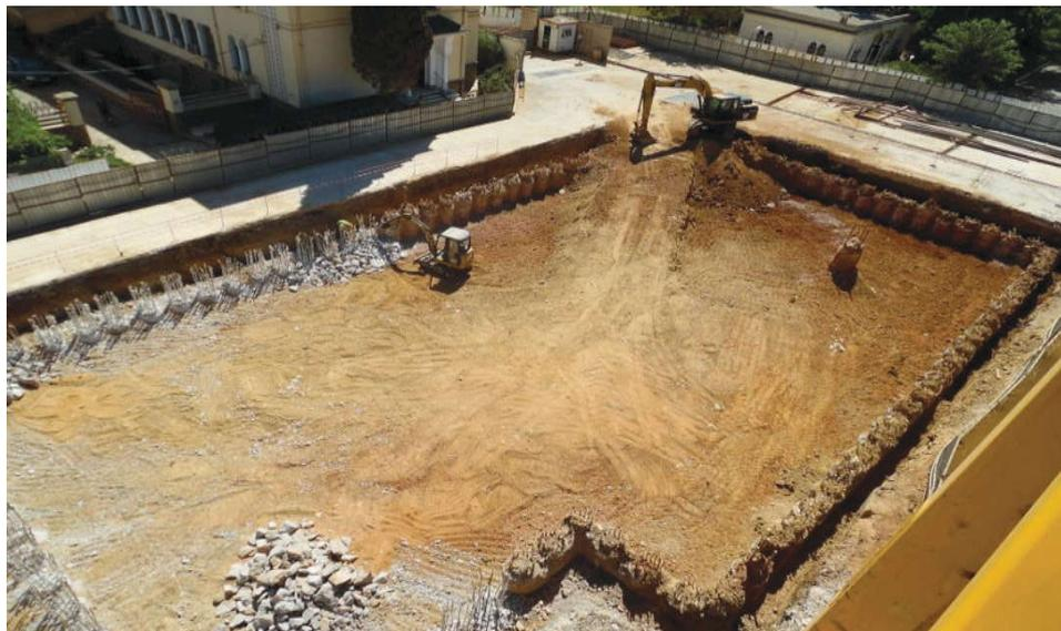
**Figure III.22 : Opération du recépage des pieux.**
