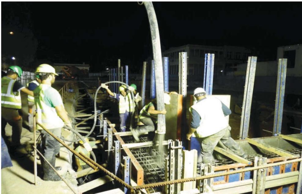
**Figure III.26 : Coulages des poutres.**
