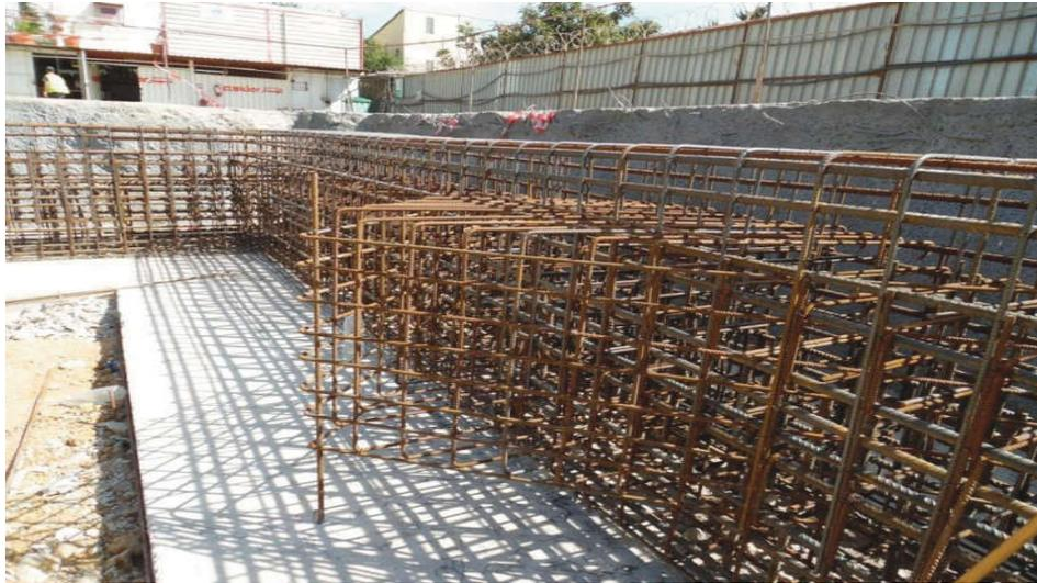
**Figure III.25 : Ferrailage d'un massif d'appui.**
