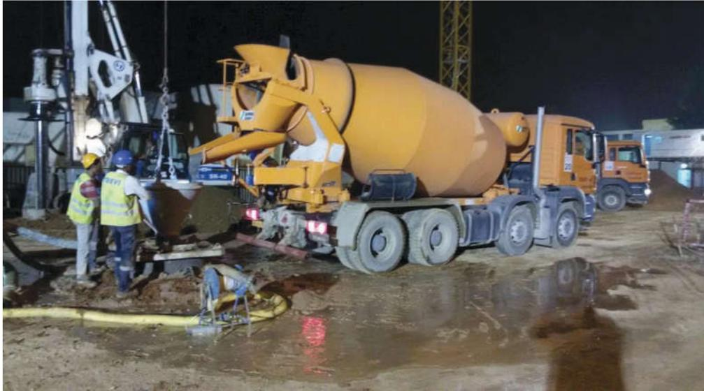
**Figure III.21 : Opération du coulage des pieux.**
