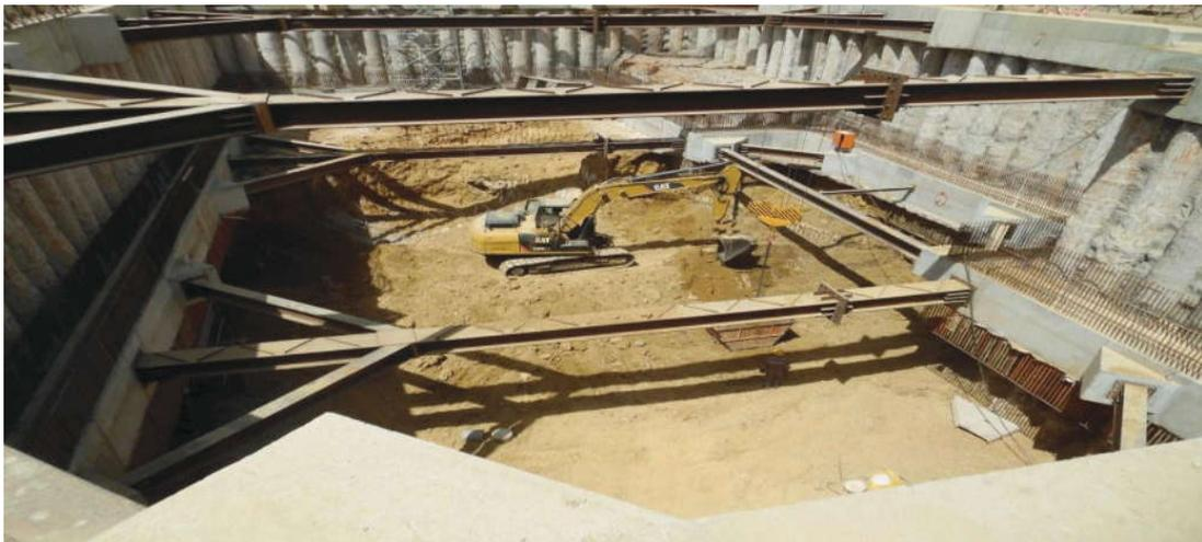
**Figure III.32 : Excavation du puits verticale.**
