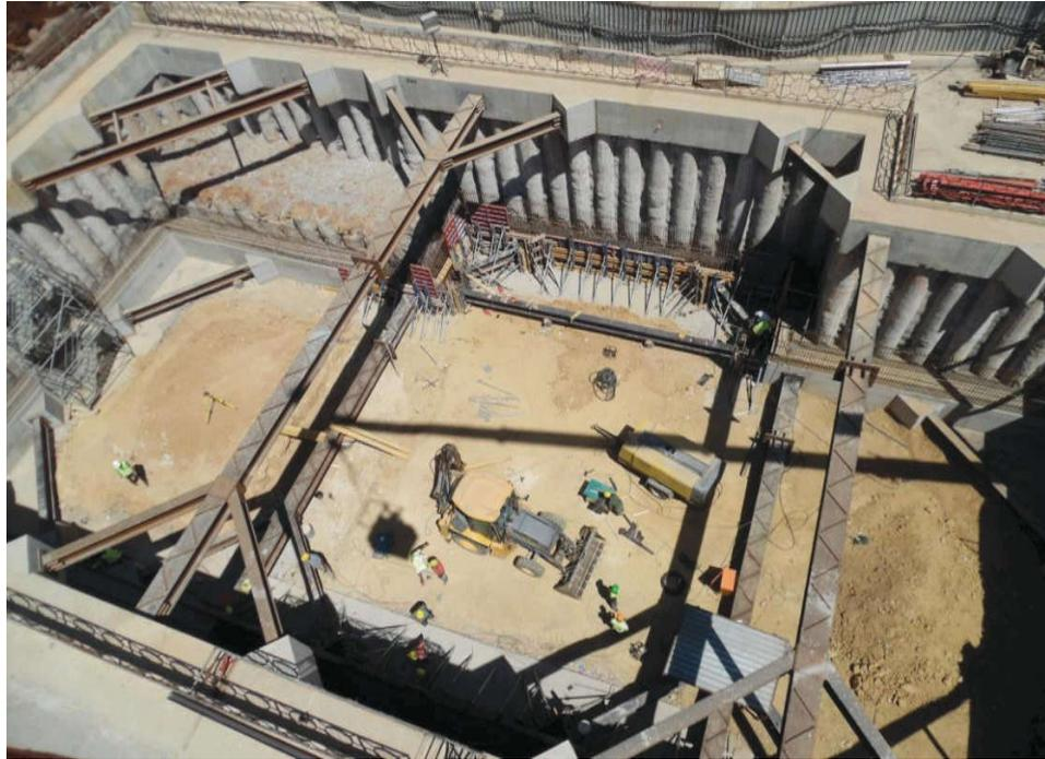
**Figure III.31 : Mise en place le deuxième niveau de butonnage.**
