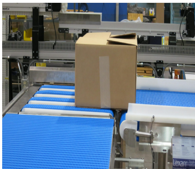
Figure II.6 : Exemple de manutention par convoyeur
