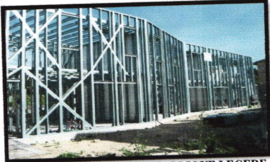
FIG141.STRUCTURE METALLIQUE LEGERE SOURCE : http://www.agexea.com
