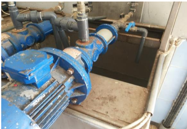
Figure 2. 12: Unité de préparation de polymère.
