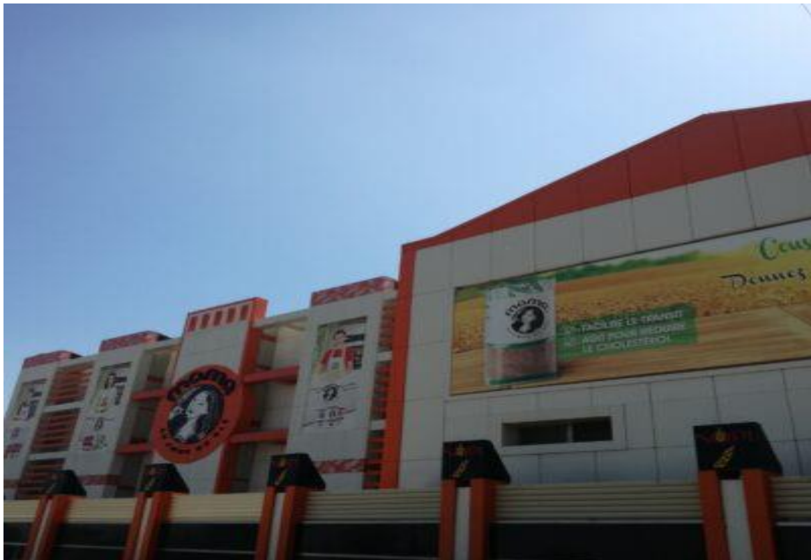
Figure 1.1 : Entrée de l'usine Mama
