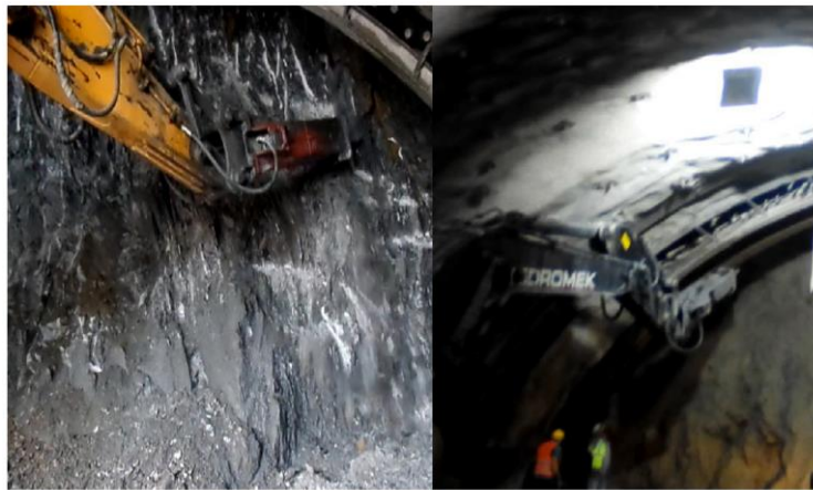
Figure II.2. Machines d'attaque ponctuelle/brise roche utilisé dans un tunnel
