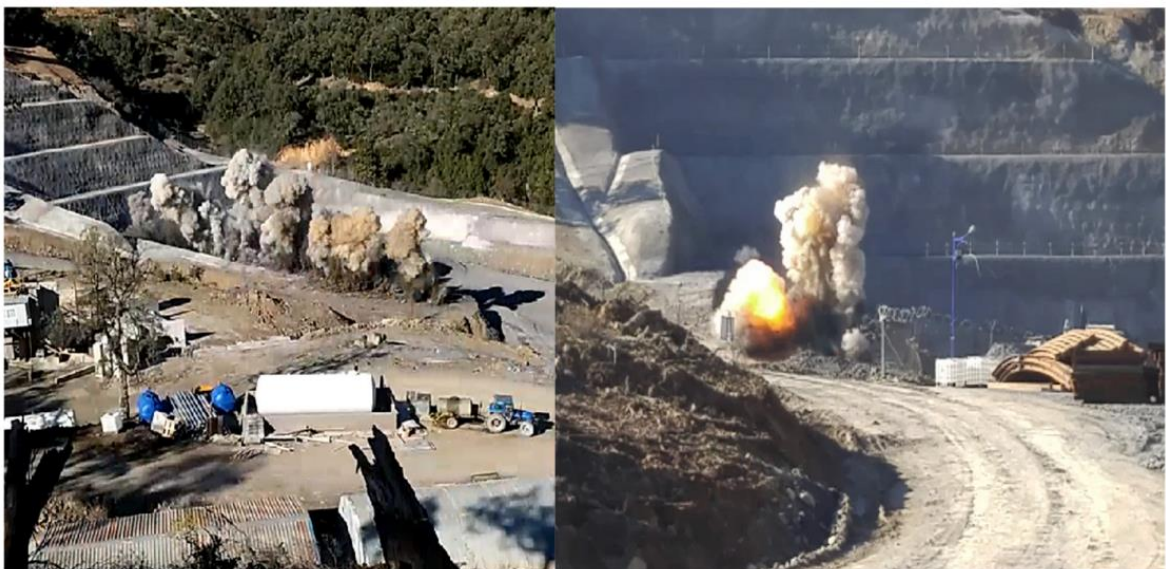
Figure II.1. Explosif utilisé sur le portail d'un tunnel
