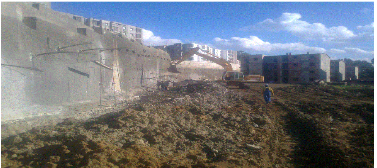
Figures I.20: Mur à paroi tirantée (Boumerdes ,2012)
