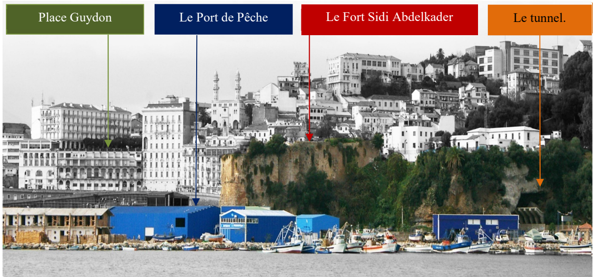
Fig. 3.19 Photo d'une partie du front maritime de Bejaia, 2013 prise et traitée par l'auteure depuis la jetée Sud
