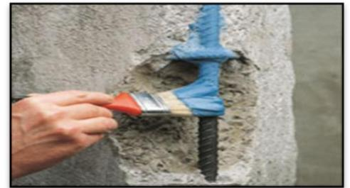
Fig.35 : -Utilisation de peinture hydrofuge contre la corrosion-
