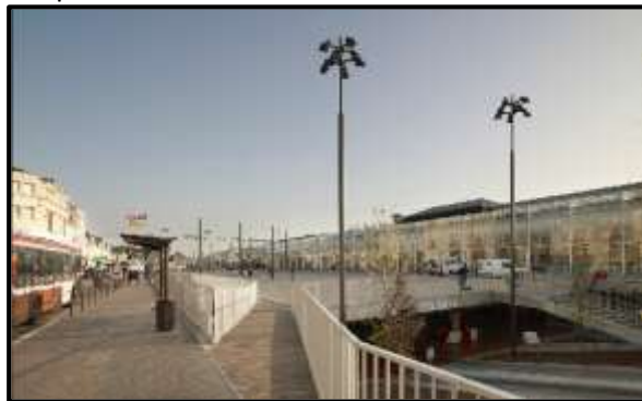
Figure 63 PÔLE MULTIMODAL AU MANS_AREP
