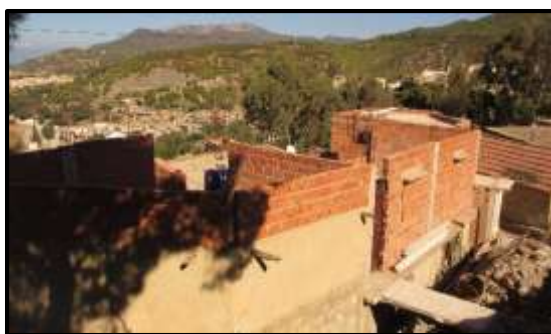
Figure 40 la construction au dessus des habitat traditionnels
