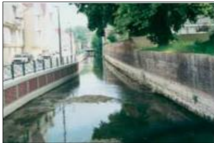
Figure 104. Parement en brique Source : TR3--fleuve logistique et environnement
