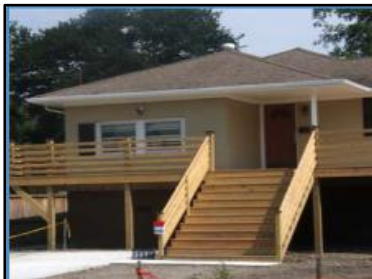
Figure 76. Réhaussement des habitations source : www.norfolk/city.com
