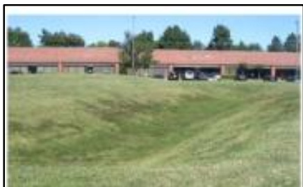
Figure 66. utilisation des bermes source : www.wikipedia.org
