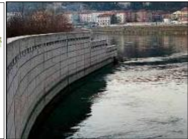
Figure 102. Parement en pierre Source : TR3--fleuve logistique et environnement
