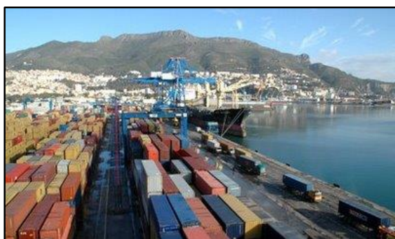
Figure 125. Port industriel de Bejaia source : www.dzairnews.com/articles/elwatan-blocage-des-equipements-de-cevital-au-port-de-bejaia-reagissez
