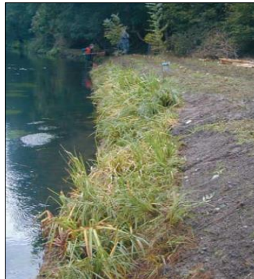
Figure 108. Mise en place du géotextile Source : TR3--fleuve logistique et environnement
