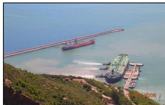
Figure 126. port pétrolier de Bejaia source : www.panoramio.com/photo/2233708
