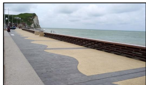
Figure 8. Esplanade en béton -Veulettes-sur-Mer-France Source : http://bybeton.fr
