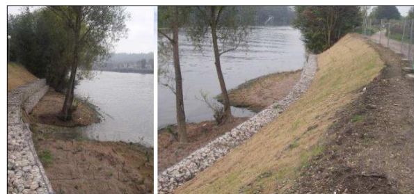
Figure 100. Etat des lieux après l'intervention Source : TR3--fleuve logistique et environnement
