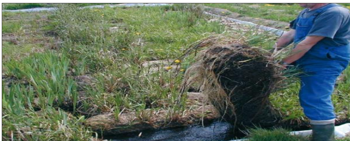
Figure 106. Mise en place d'une couche végétale
