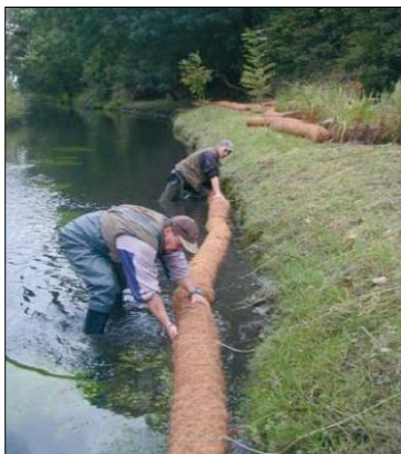
Figure 109. Mise en place du géotextile Source : TR3--fleuve logistique et environnement
