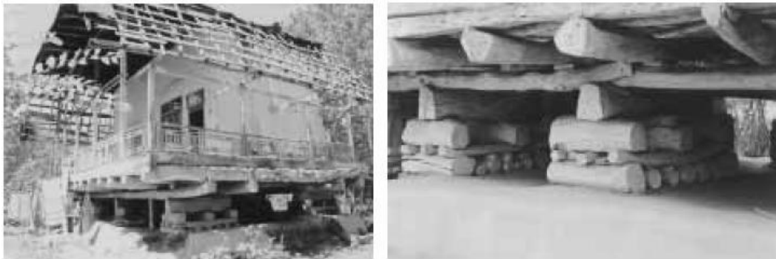
Figure 1 : Morceaux de bois installés entre la base et le palier des maisons en Iran.
