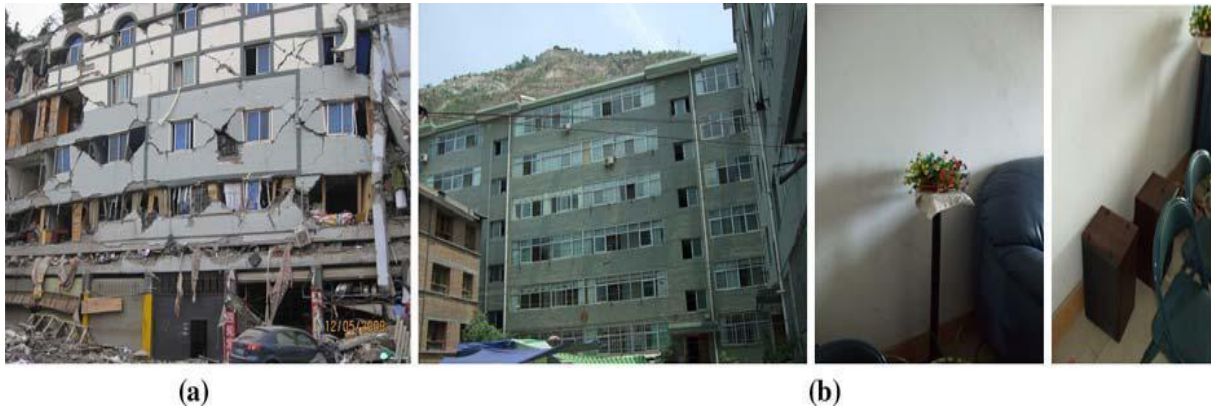
Figure 19: Conséquences du séisme de Wenchuan (Chine) en 2008
