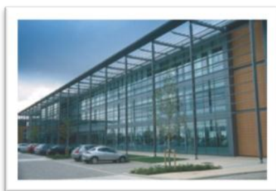
Fig. 50 :La protection solaire - Brise soleil
