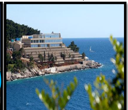
Fig.1.67 : La construction de l'hôtel est en gradin orienté vers la mer avec des ouvertures en bow-windows et des grandes terrasses pour chaque chambre Source : www.googleimage.com
