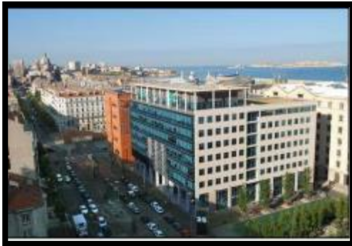
Fig.02.37 : Immeuble des bureaux cap Juliette. Source : www.googleimage.com
