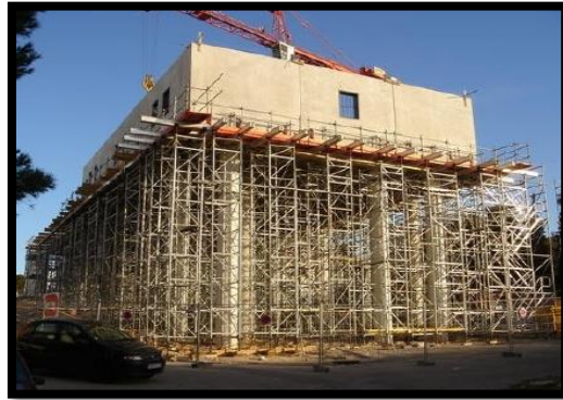
Fig.02.57 : Grand chantier hospitalier.
