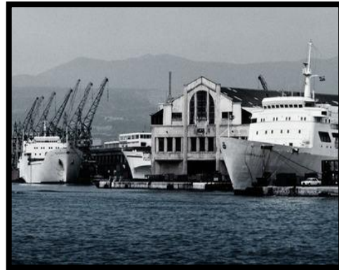
Fig.1.50 : Hangar au port de Marseille. Source : www.googleimage.com
