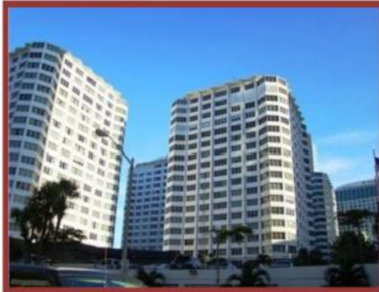
Figure 19: Exemple d'habitat collectif 02
