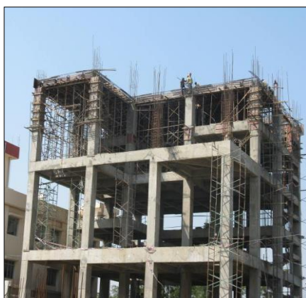
Figure 164: Structure en béton armé.
