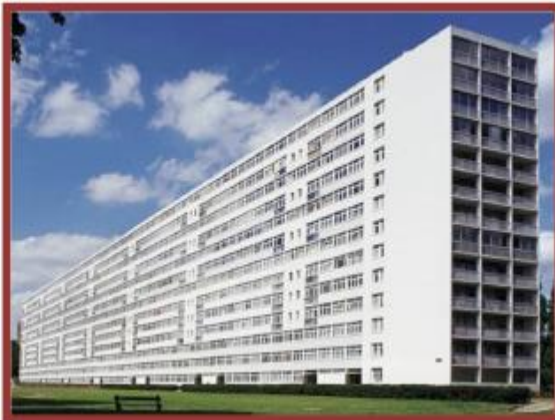
Figure 18: Exemple d'habitat collectif 01
