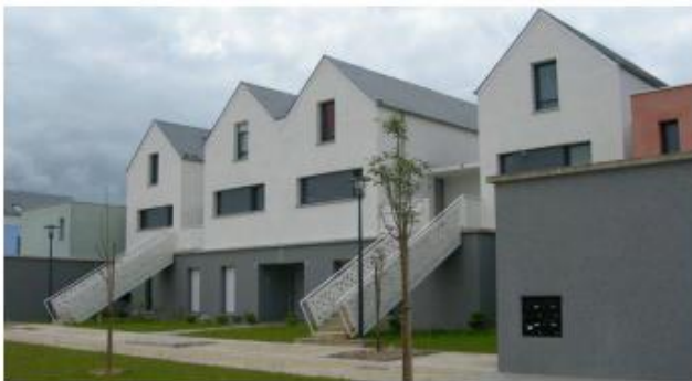
Figure16 : La main courante de l'escalier et le garde corps donne de la qualité à la façade. Le Rheu
