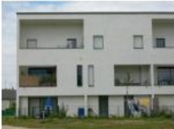
Figure22 : Un aménagement de cour d'îlot face Betton aux terrasses. Chantepie
