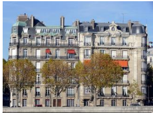
Figure25 : habitat collectif France.
