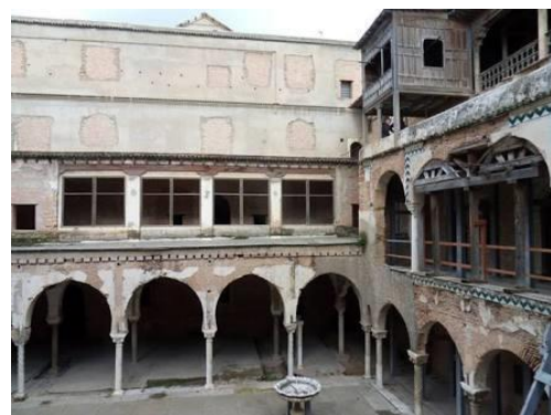
Figure8 : Restauration de la citadelle d'Alger
