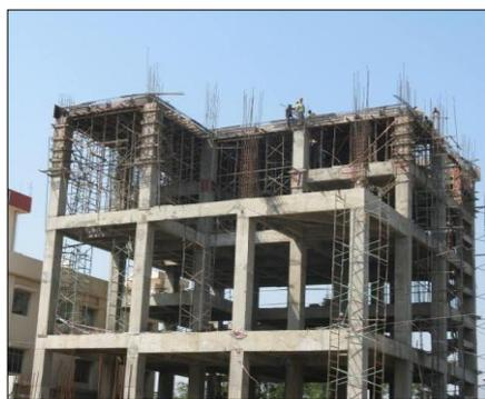
Figure 107 : Structure en béton armée.
