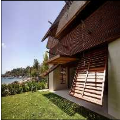
Image 01 : des brises soleil en façade amovible. Source : https://architizer.com
